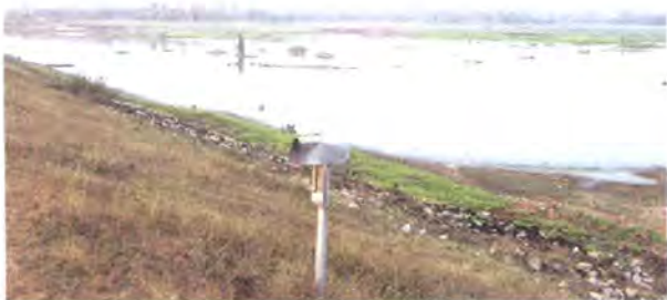
รูปที่ 5.1.1.2 สภาพสระเก็บน้ำที่จะนำน้ำมาเติม
