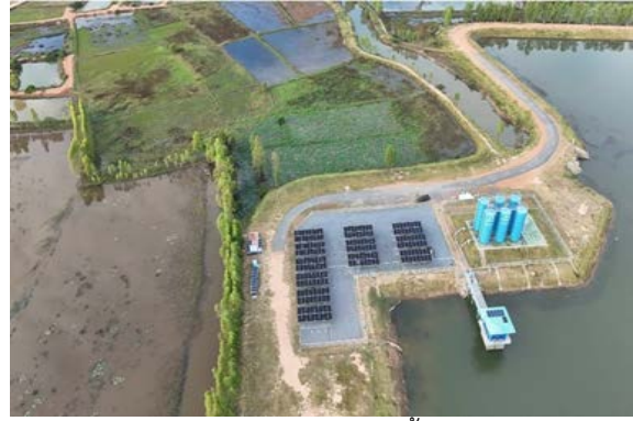
งานบำรุงรักษาโครงการแหล่งน้ำธรรมชาติ
